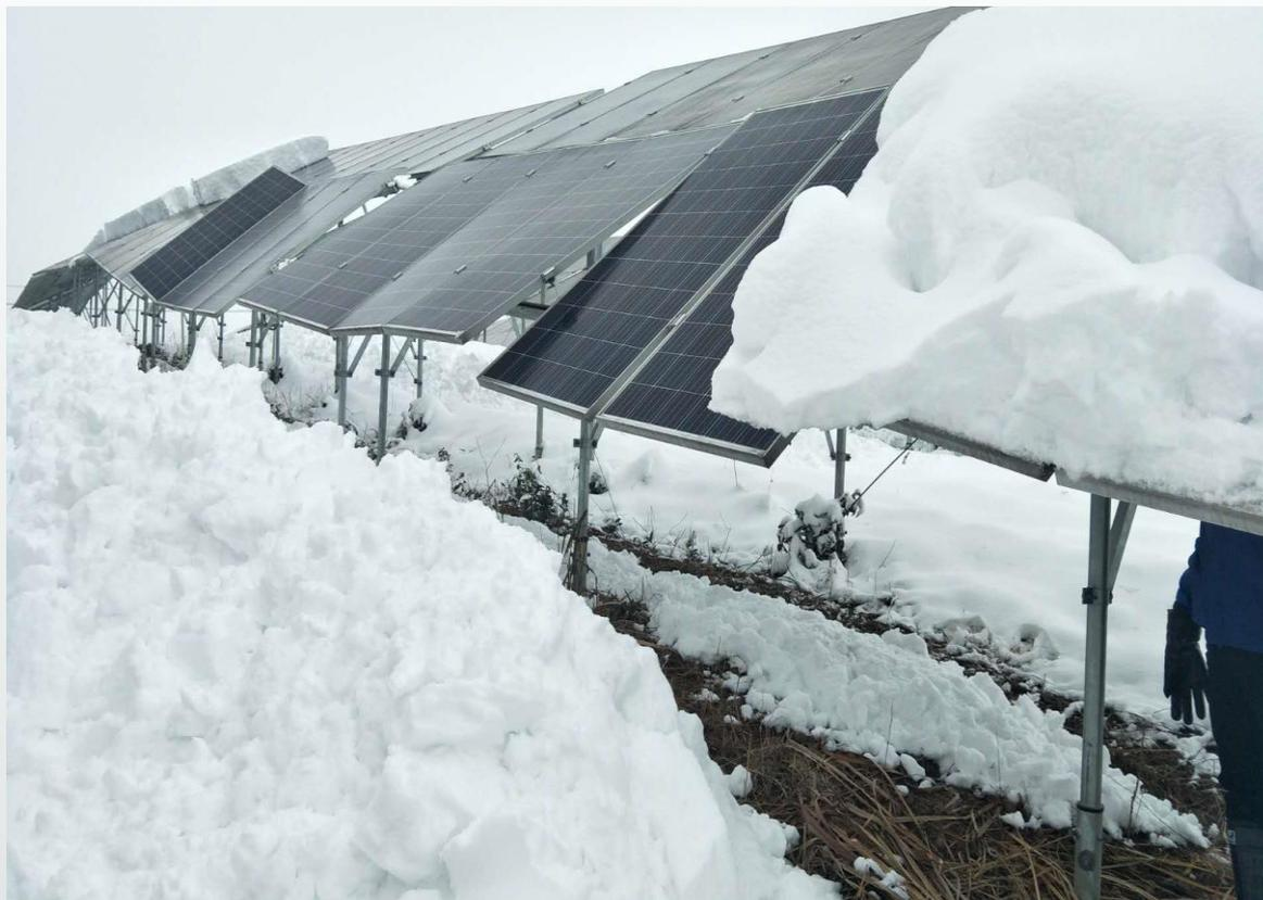
2018年初，安徽北部某30MW项目遭受持续低温雨雪灾害，根据当地气象局观测数据显示，24小时累计降雪量超过72mm，且期间夹杂雨夹雪，因积雪含水量较大，导致厂区范围内的部分平单轴支架组件及立固支架组件发生严重损失，大量光伏支架及立柱变形弯曲，支架变形还造成部分组件面板碎裂或背板被挤压刺穿。直接经济损失超过100万元。
