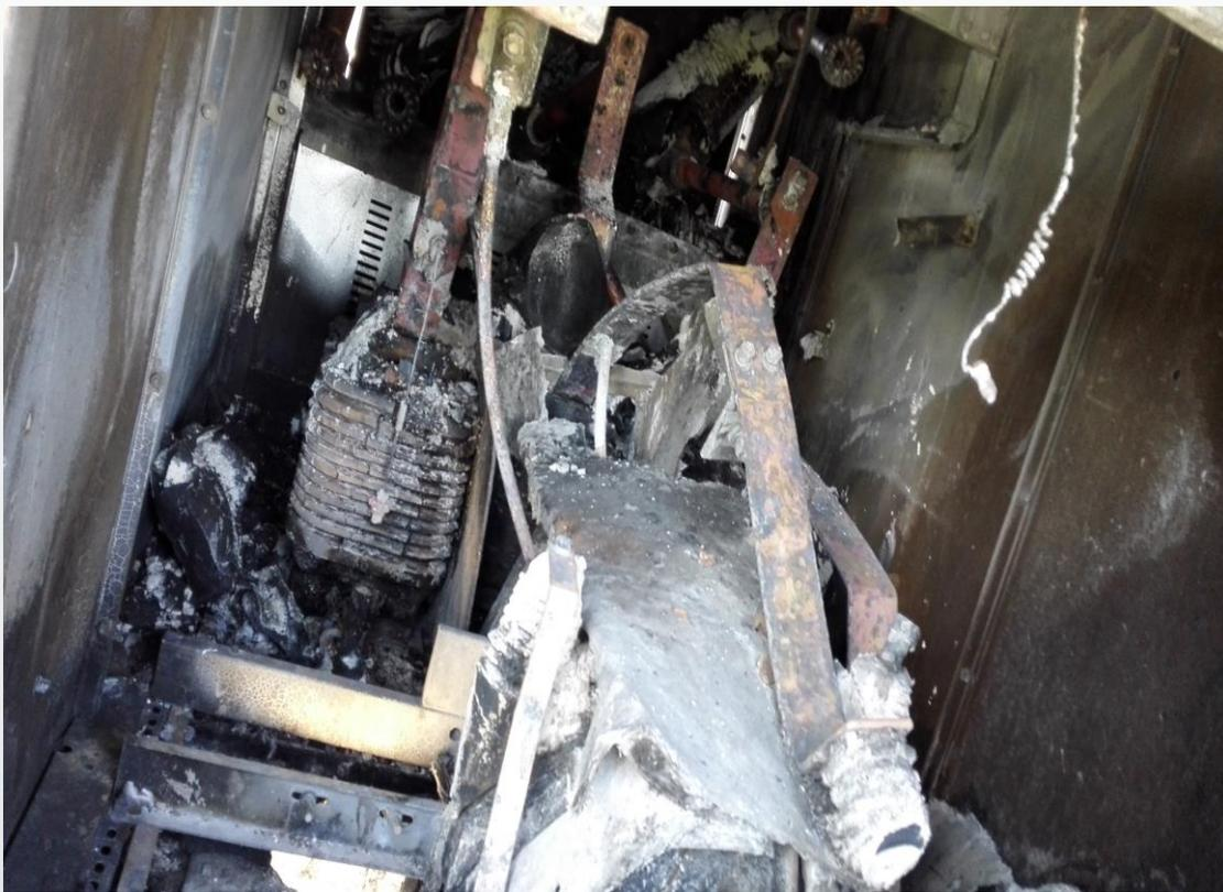
2017年9月，安徽某30MW运行项目在检修送电过程中，35KV一次舱PT柜发生短路爆炸事故，并引发电气火灾，造成一次舱本体、舱内多组高压柜受损及间接发电量损失。直接损失超过150万元，发电量损失超过100万元。
