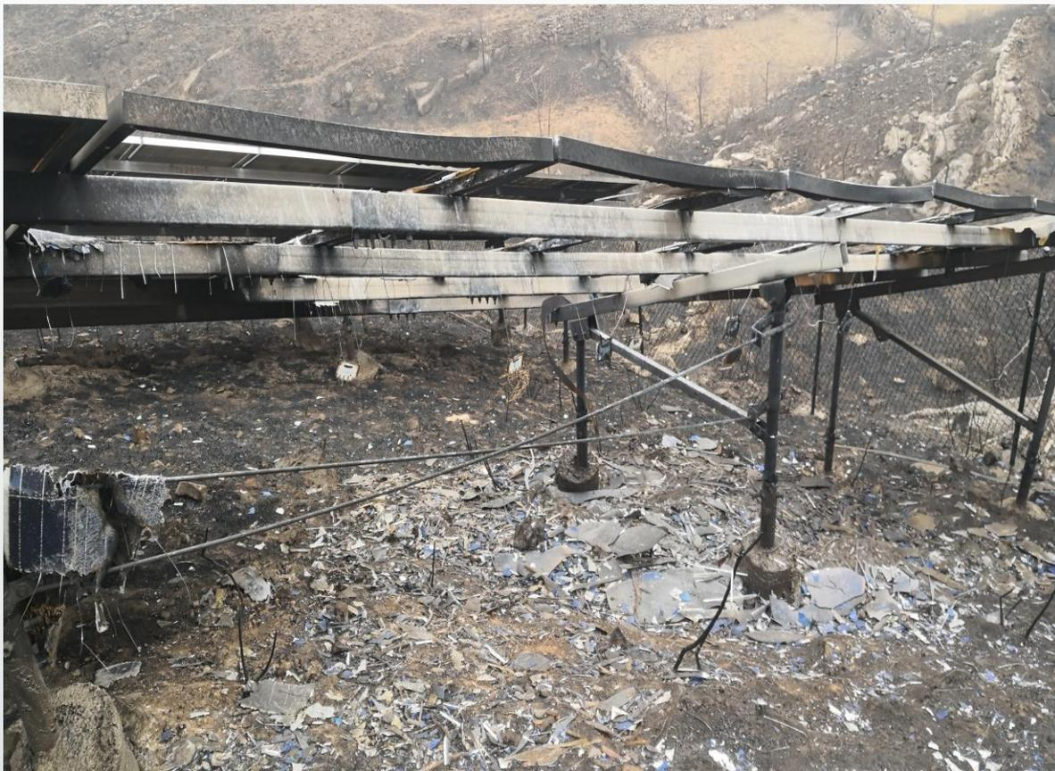
2018年3月，河北南部某100MW项目发生重特大火灾事故，经事后调查，火灾由当地村民节日祭祀引起，整个火灾过程历时近5天，阶段性灭火后又发生多次复燃，造成该地区5家光伏电站厂坪区起火，过火总面积超过2000亩，造成大量组件、电缆、汇流箱设备受损，直接经济损失超过500万元，电量损失超过200万元。
