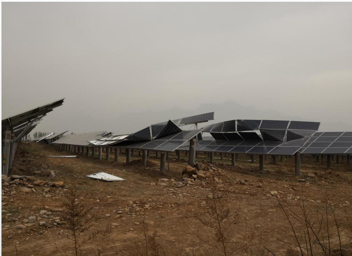
2017年4月，河北某50MW在建项目，发生9级以上暴风天气，观测点瞬时最大风速超过27.2米/秒，最大风速持续时段历时近3个小时，全厂受损组件约1MW，近3000片组件发生隐裂、破片或面板直接碎裂，大量光伏支架变形受损，直接经济损失超过300万元。
