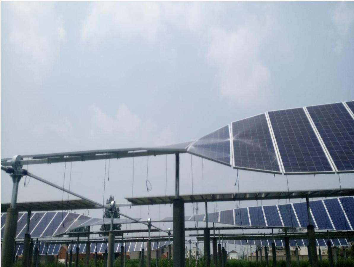
2016年6月，江苏某20MW在建项目，发生9级以上暴风天气，全厂受损组件约2500片，大量组件发生隐裂、破片，大量平单轴支架、横梁、传动轴发生扭曲变形受损，直接经济损失超过300万元，同时造成工期交付延误。
