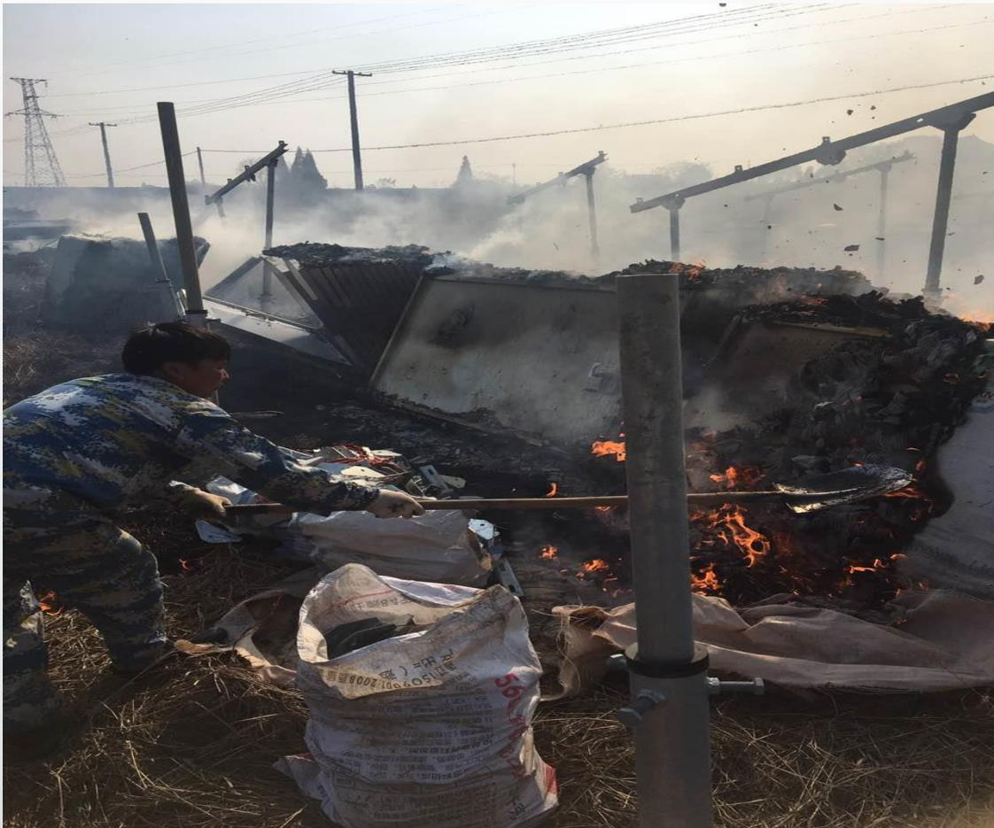
2017年12月，浙江南部某20MW项目发生火灾事故，经事后调查，火灾由周边村民遗留火种造成，经统计，火灾造成近1000片组件受损，另有部分电缆、汇流箱设备受损，直接经济损失超过100万元。
