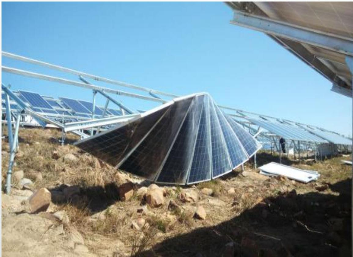
2015年9月，河南某100MW在建项目，发生10级以上暴风天气，全厂受损组件约2MW，近7000片组件坠地后发生隐裂、破片，大量光伏支架变形报废，直接经济损失超过700万元，同时造成工程延期交付，对当年电价备案造成严重影响。
