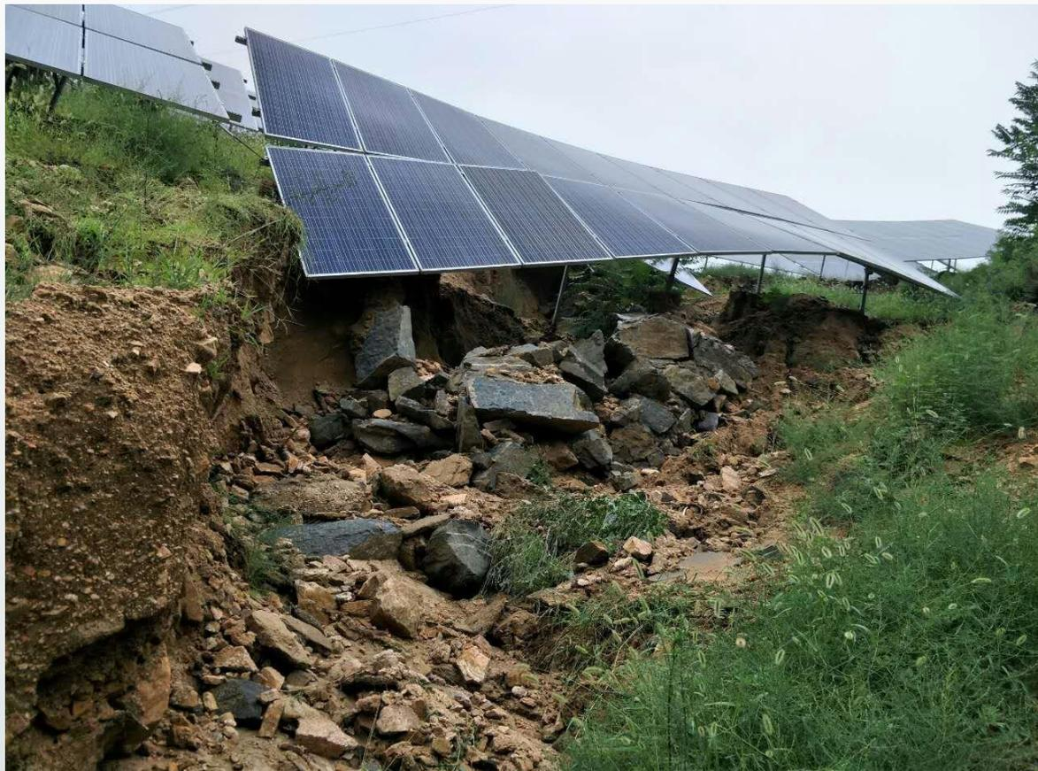
2017年汛期，河北某50MW在建项目遭受特大暴雨及洪涝灾害，根据当地气象局观测数据显示，24小时内降雨量达到168mm，因该项目地处山区，厂坪落差较大，大量上游洪水流入并冲刷厂区，造成大量汇流箱、光伏组件、桩基础及土建设施等项目大范围受损，直接经济损失超过200万元。
