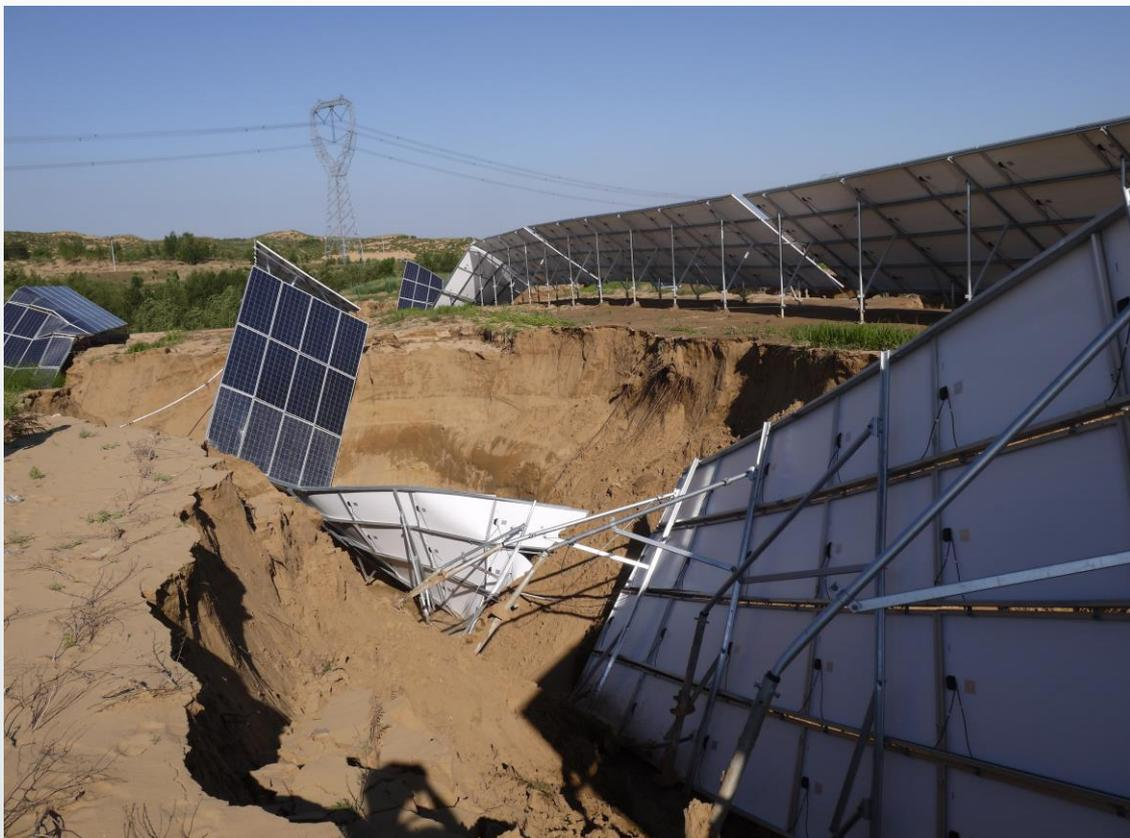
2017年汛期，西北某省份100MW在建项目，遭受特大暴雨及洪水、泥石流灾害，洪水流经区域产生大量冲击沟，电缆及通讯光缆被冲断，光伏阵列地锚基础被雨水冲刷后外露并造成组件支架整组倾斜或倾覆，直接经济损失超过500万元。
