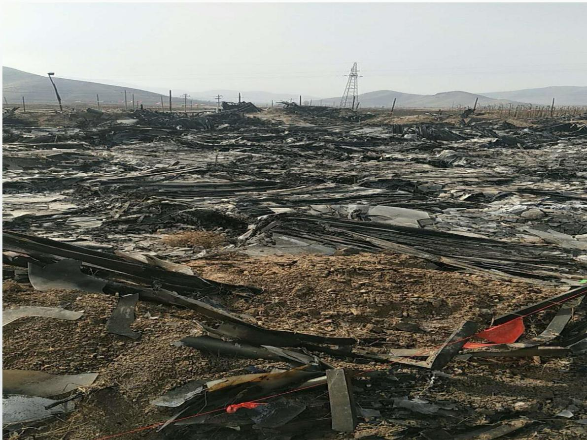
2018年2月，河北北部某100MW在建项目发生重特大火灾事故，经事后调查，火灾由于施工单位现场遗留火种造成，事故造成约3MW组件全损，直接经济损失超过500万元。
