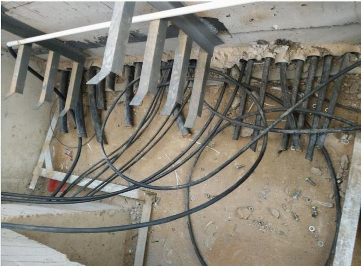
2015年10月，甘肃某50MW运行项目发生逆变器电缆被盗事故，经事后排查，有7间逆变器室的3\*240和2\*70阻燃绝缘铜芯电缆被盗，受损电缆总长度超过1000米。直接损失接近40万元，发电量损失超过10万元。
