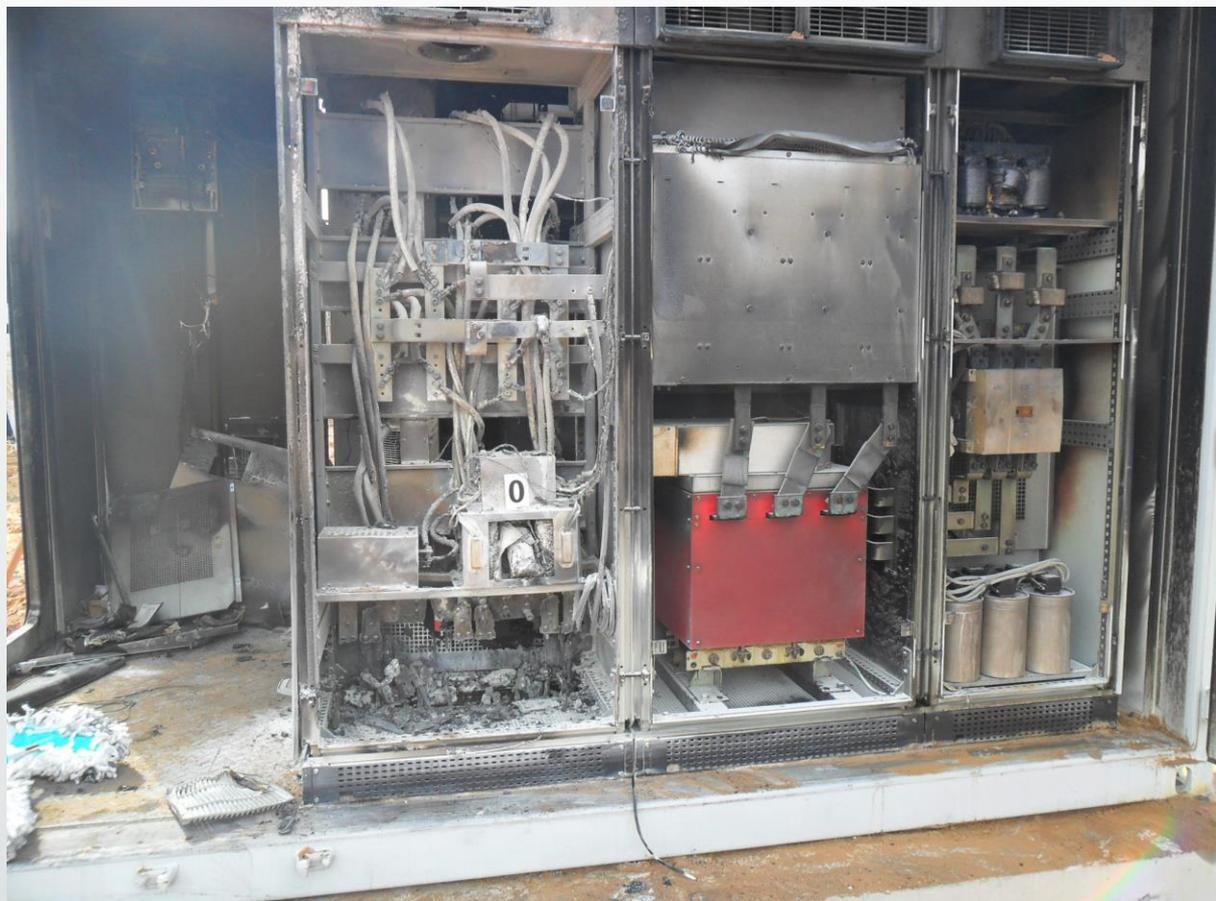
2017年11月，陕西某50MW运行项目厂区集中式逆变器直流输入配电柜短路，并引发电气火灾，造成室内两台逆变器主要单元构件、设备舱体、交直流电缆等受损及间接发电量损失。直接损失超过50万元，发电量损失超过30万元。
