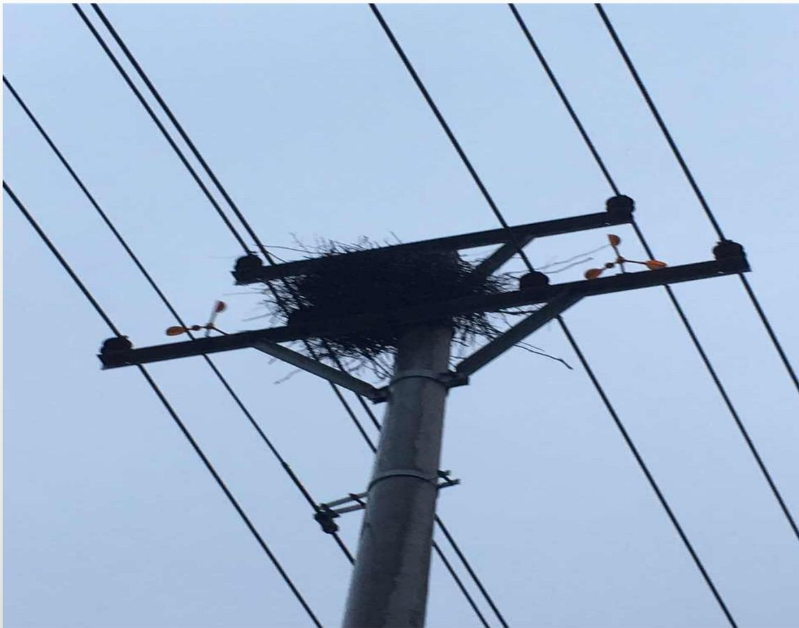
2017年初，河北某30MW运行项目发生集电线开关母差保护动作跳闸，经事后调查，事故原因为杆塔上方发现鸟窝，在降雨天气中发生AB相短路接地故障，引发保护开关跳闸。发电量损失超过50万元。
