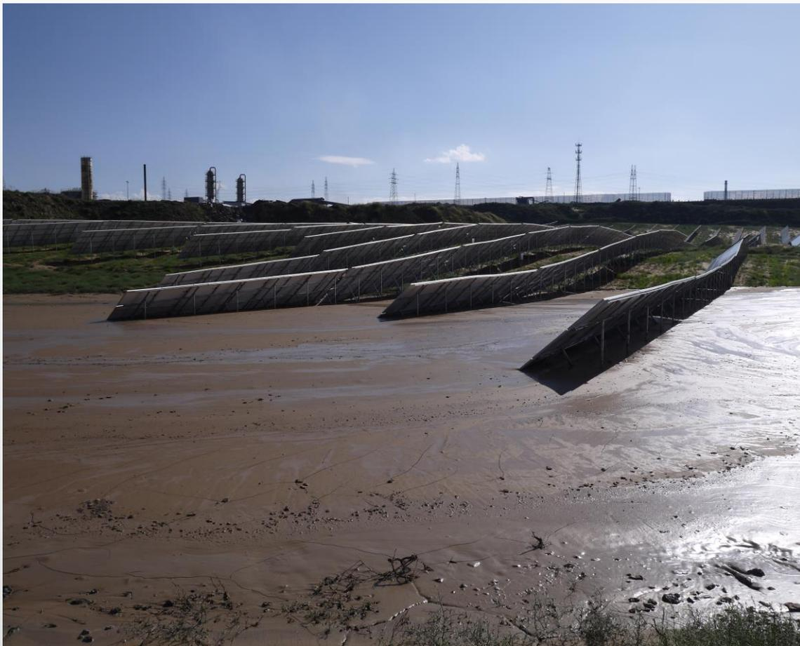
2016年汛期，西北某省份500MW在建项目，遭受特大暴雨及洪水、泥石流灾害，48小时内降雨量达到318mm，局地发生山洪、滑坡、泥石流等地质灾害，小时雨强和过程雨量均超过历史极值，洪水流经区域产生大量冲击沟，厂坪破坏严重，淤泥流沙大量沉积，部分箱逆变基础被淤泥掩埋，电缆及通讯光缆被冲断，光伏阵列地锚基础被雨水冲刷后外露并造成组件支架整组倾斜或倾覆，下游地势低洼区域淤泥聚集，部分光伏支架被局部或整体掩埋，下游村镇及部分农田被掩埋，排洪沟阻塞，直接经济损失超过2500万元。
