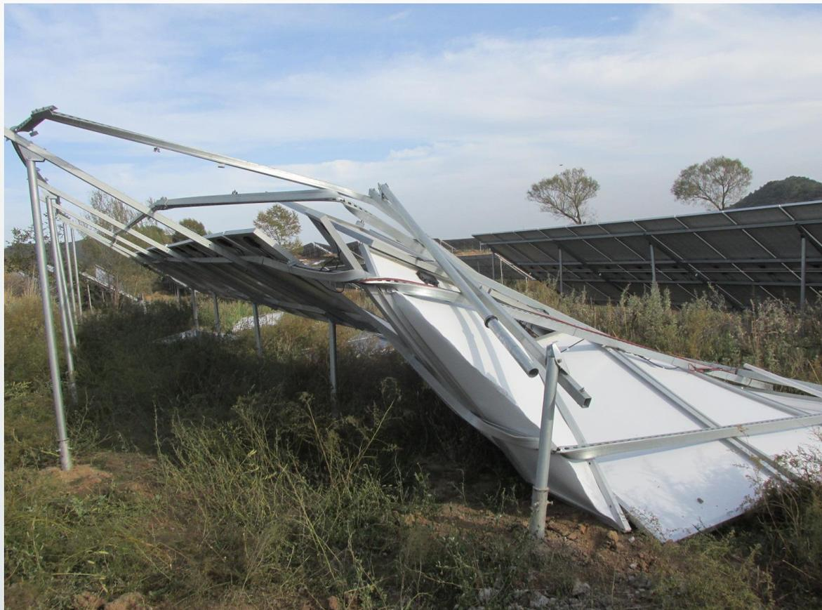
2015年10月，山西某50MW在建项目，发生9级以上暴风天气，全厂受损组件约1MW，近3000片组件坠地后发生隐裂、破片，大量光伏支架变形受损，直接经济损失超过300万元。
