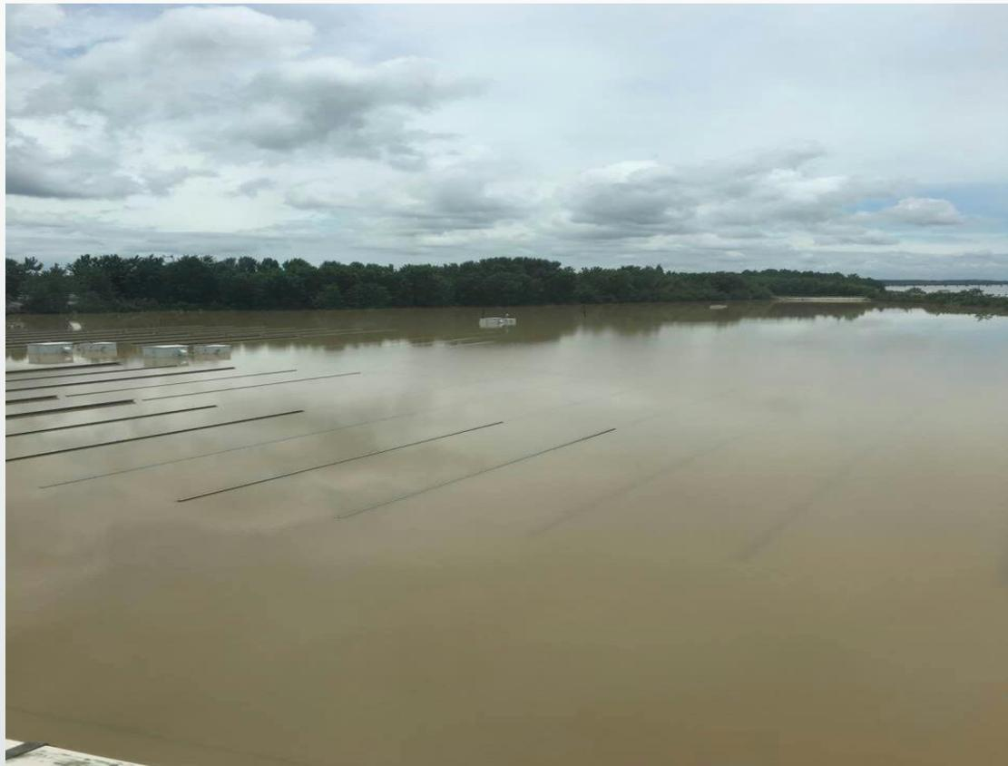
2016年7月，湖北某110MW在建项目遭受特大暴雨及洪涝灾害，根据当地气象局观测数据显示，24小时降雨量达到389mm，周边10余座水库漫堤、泄洪，导致光伏厂区内大面积内涝积水，积水最深处超过2.5米，造成一、二期光伏场地被洪水直接倒灌，严重的洪涝灾害致厂区内80%以上逆变器、汇流箱、箱变、光伏组件、桩基础及土建设施等项目大范围受损，直接经济损失超过5000万元，发电量损失超过3000万元。
